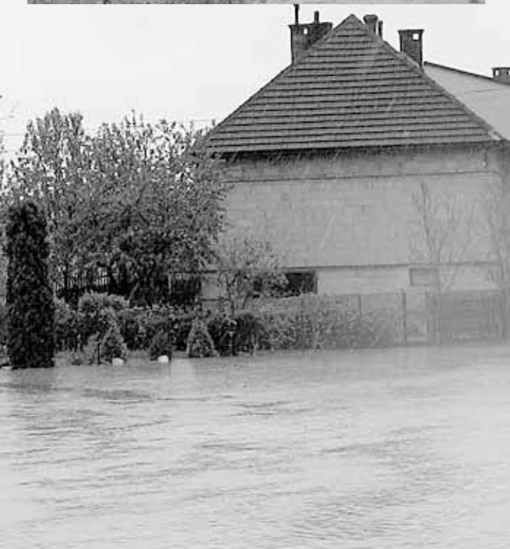
Przepompownia w Zajezierzu doświadczona przez żywioł
