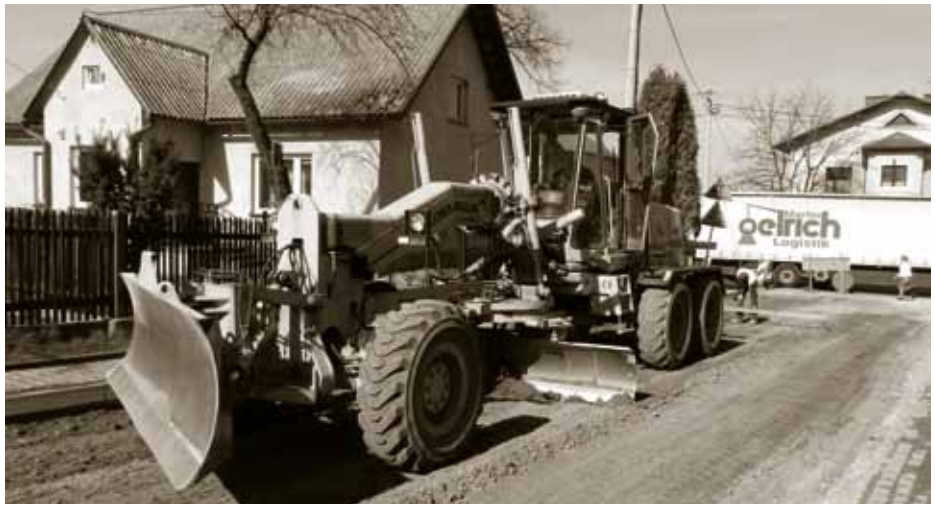
Przebudowa ulicy Długiej w Przeciszowie.
