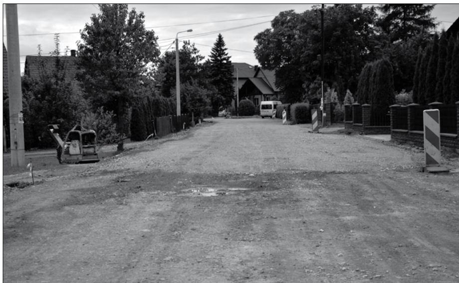
Trwa remont drogi gminnej, ulicy Długiej w sołectwie Preciszów. Prace, po których odcinek o długości 500 mb. zmieni się nie do poznania, potrważą do końca sierpnia.
