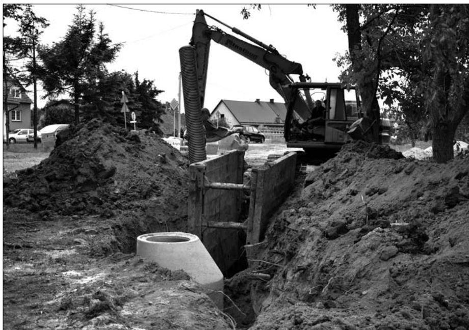
Rozpoczęła się budowa kanalizacji etap IV dla sołectwa Preciszów. Już trwają wykopy w pobliżu ulicy Jazowej. Ta część zadania inwestycyjnego ma się zakończyć w maju przyszłego roku. Realizacja obu etapów kanalizacji pochłonie ok. 32 mln zł.
